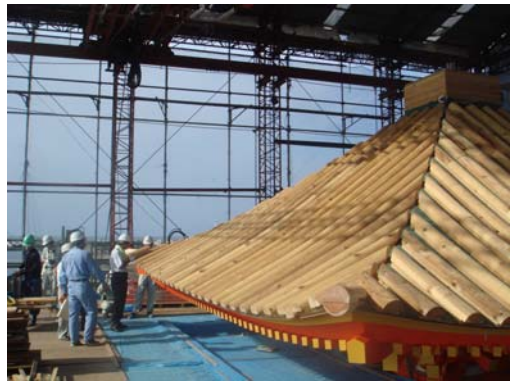
最上層（北側には利根川が望める）九輪は未施工
